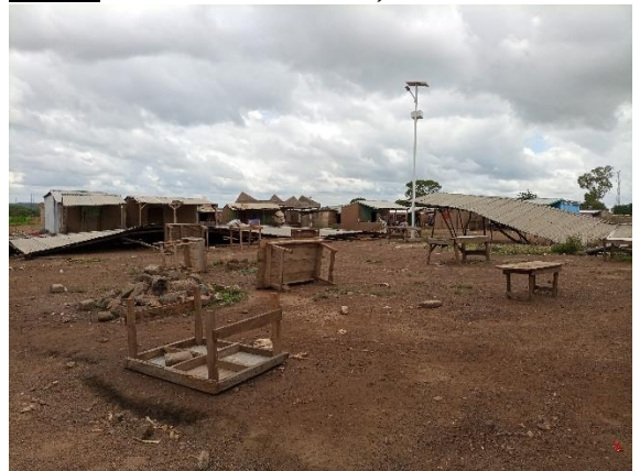
Photo 10 : Marché de Youga construit par la mine. Date : 08/09/2021.
