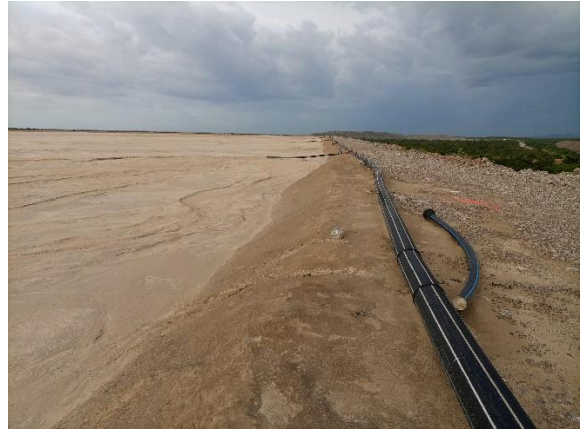
Photo 8 : Parc à résidus de Youga (TSF). Date : 08/09/2021.
